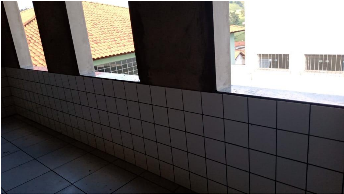
11 Colocação de Piso
