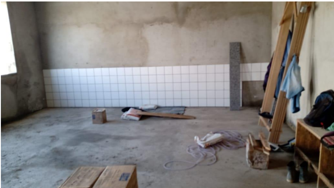
2 Colocação de Azulejos
