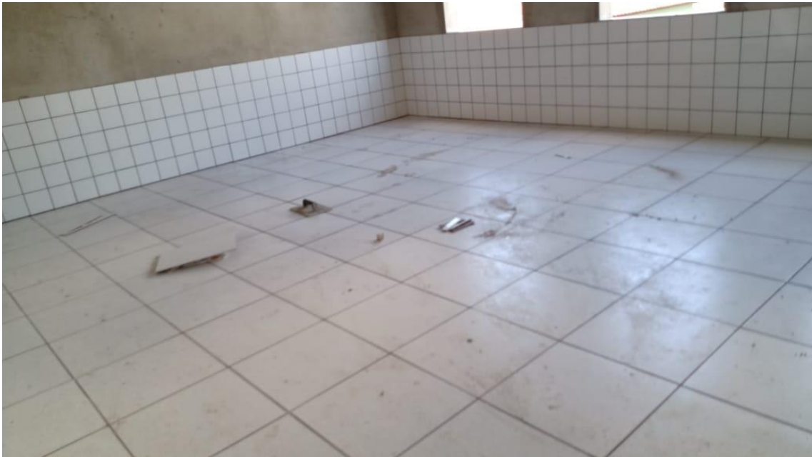
10 Colocação de Piso
