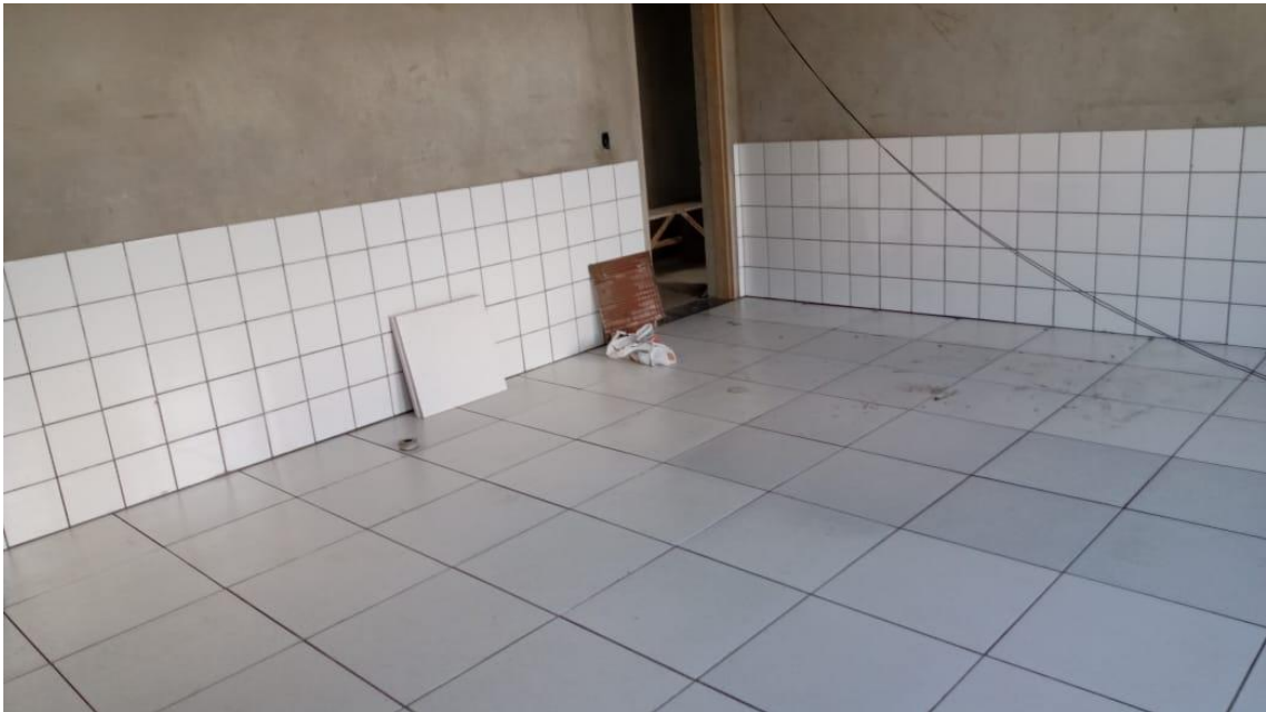
8 Colocação de Piso
