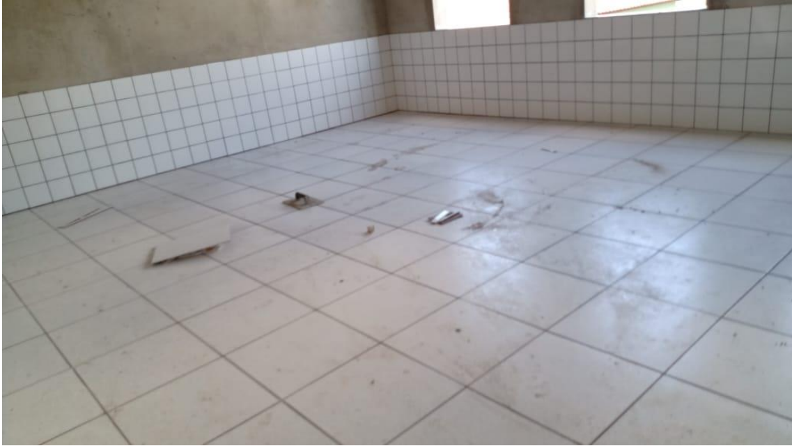
9 Colocação de Piso
