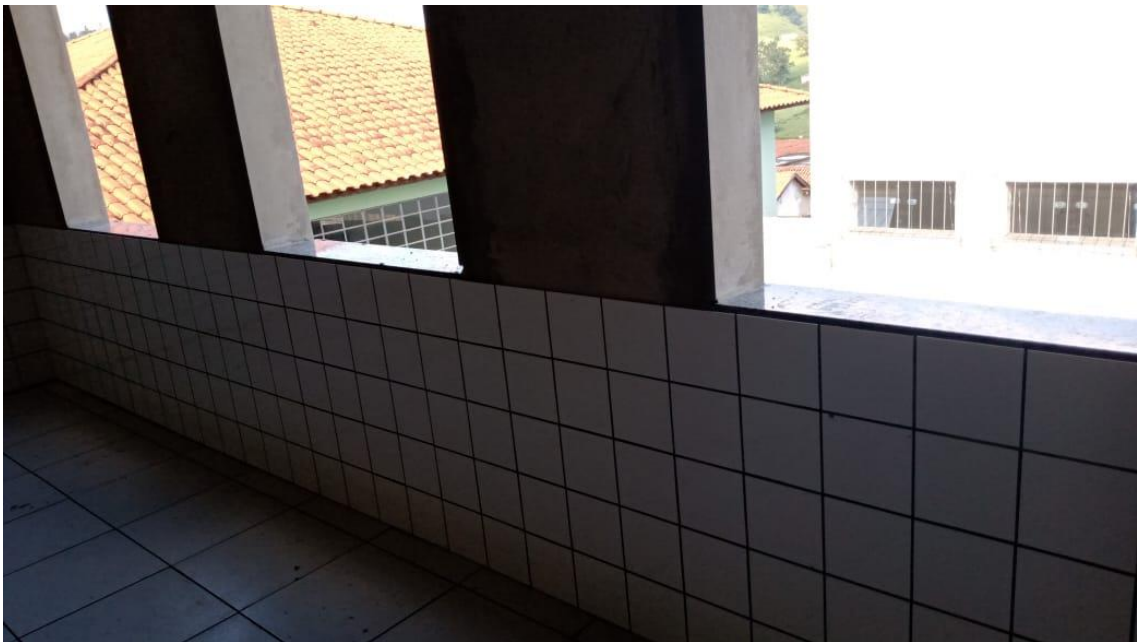
12 Colocação de Piso
