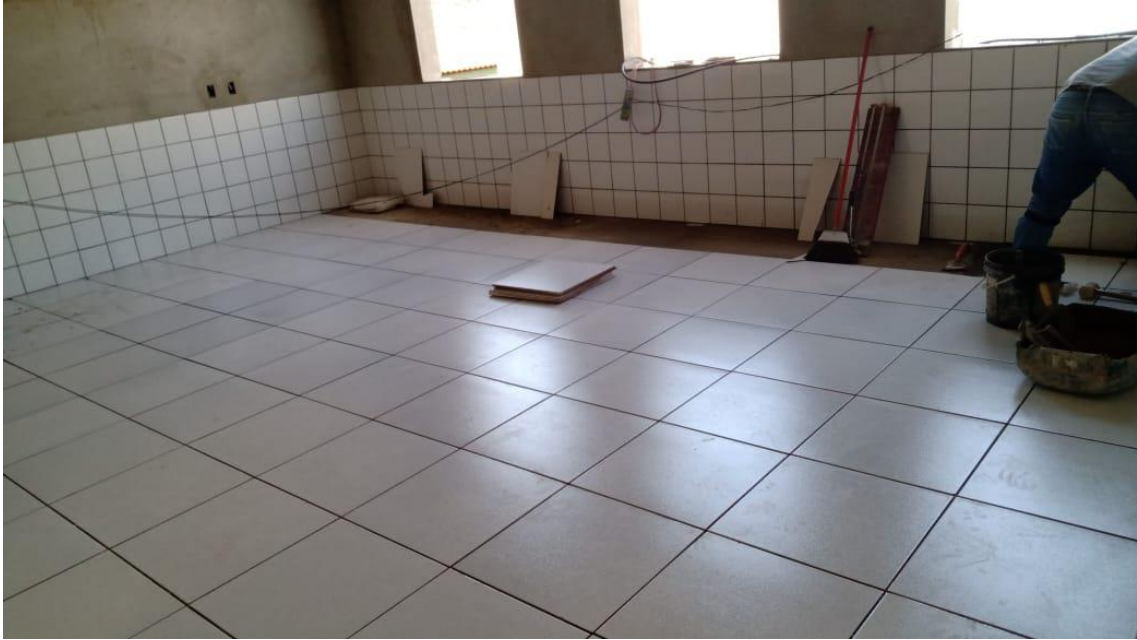
15 Colocação de Piso
