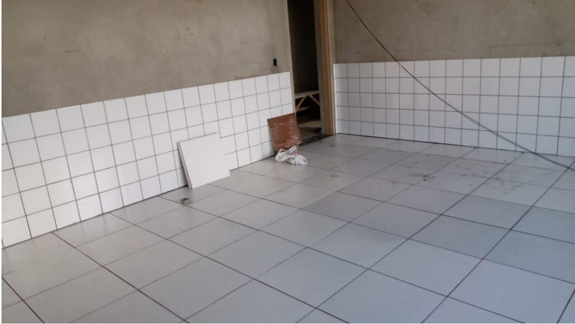
7 Colocação de Piso
