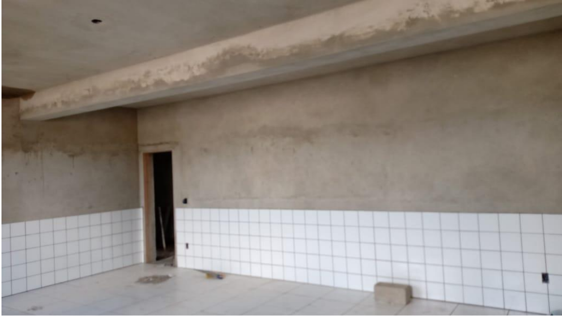
13 Colocação de Azulejos
