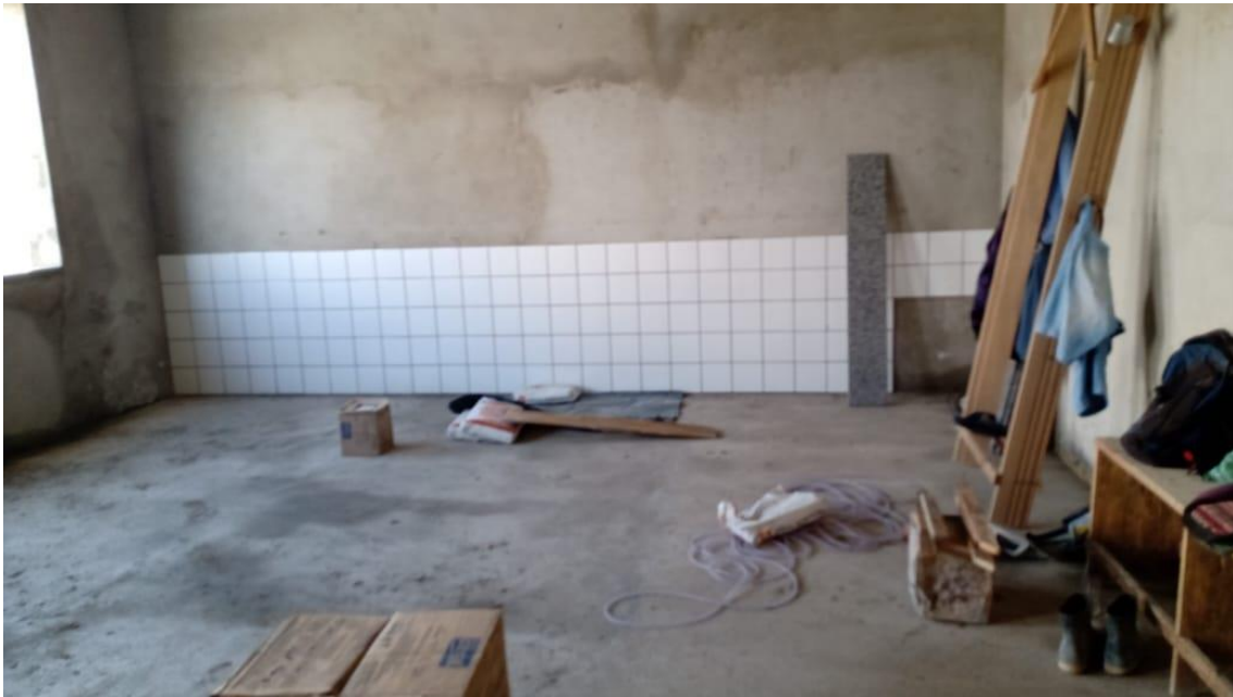
1 Colocação de Azulejos
