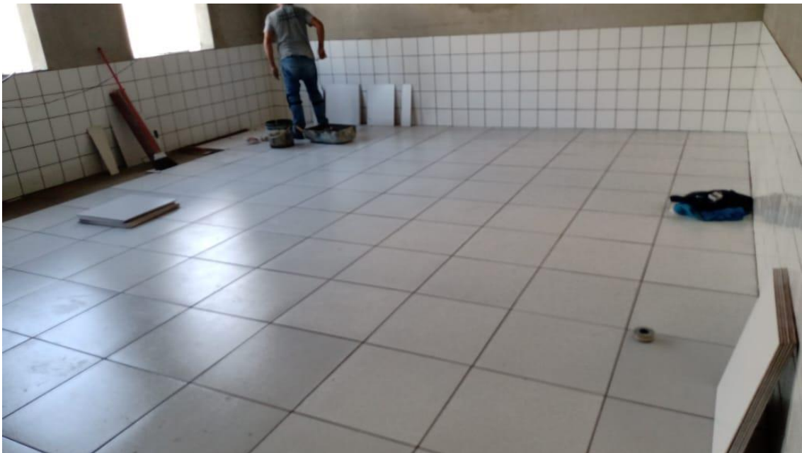
6 Colocação de Piso
