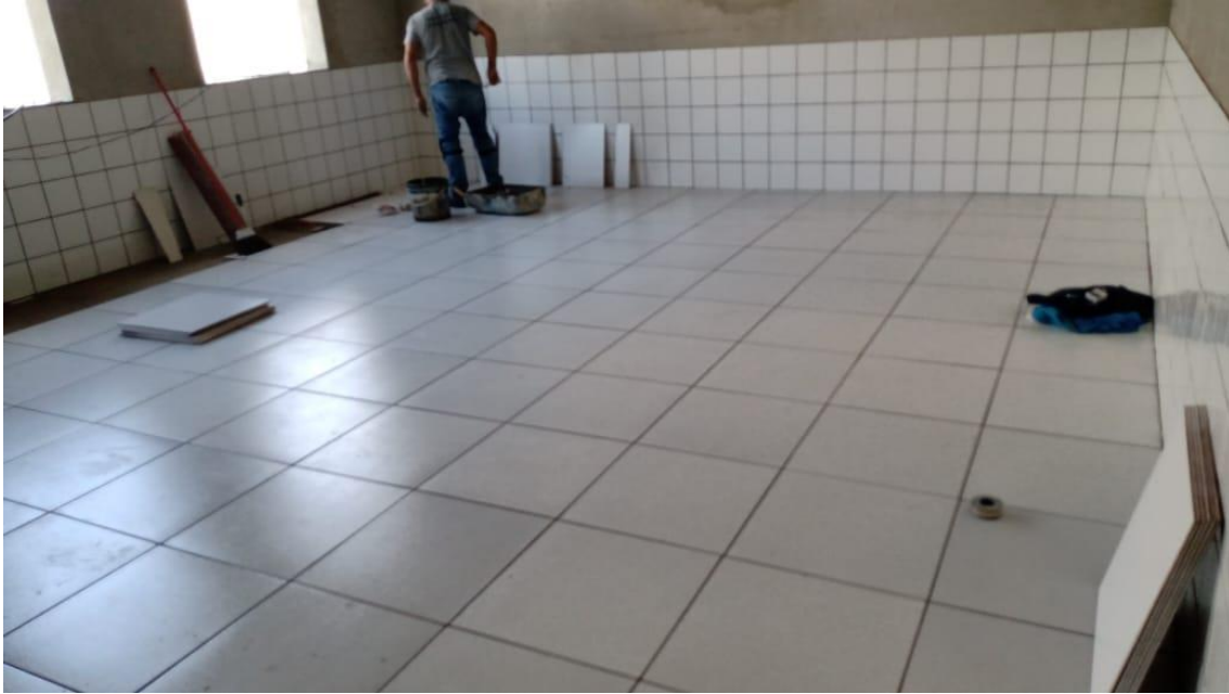
5 Colocação de Piso
