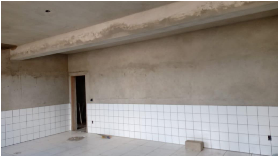
14 Colocação de Azulejos
